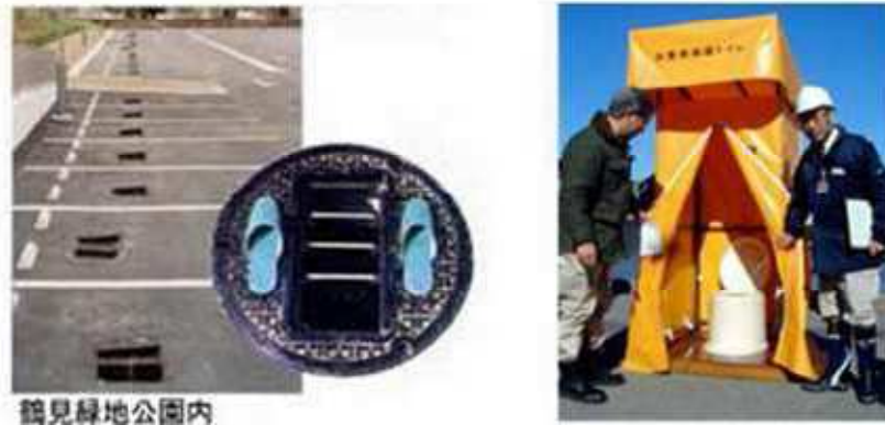
写真 6.2-1 マンホールトイレに設置するマンホール設置型トイレ例
