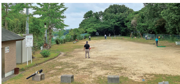
フェンスは壊れベンチもない都市公園（宮津公園）
