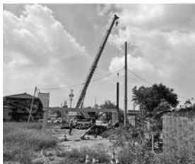
名鉄高架の西側工事 側溝・舗装工事中
