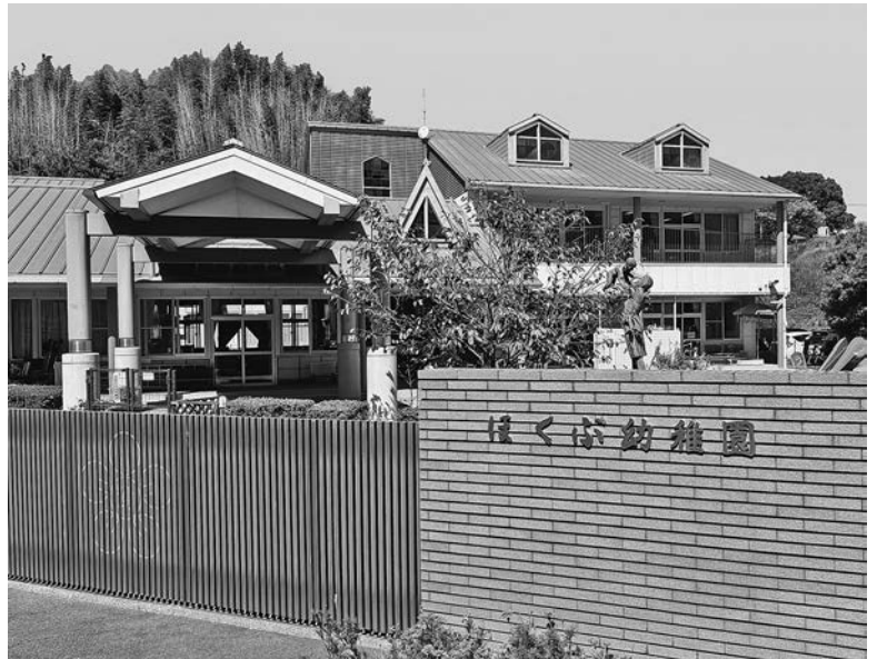
現在のほくぶ幼稚園。 令和10年度末までに園舎を解体し、地主へ返還する予定。
