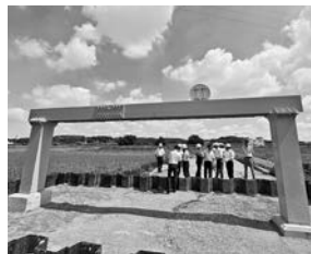
名鉄高架の東側に建設した 桁下防護ゲート(西側にもあり)
