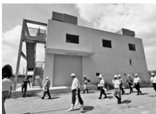
排水機場の外観（植大）
