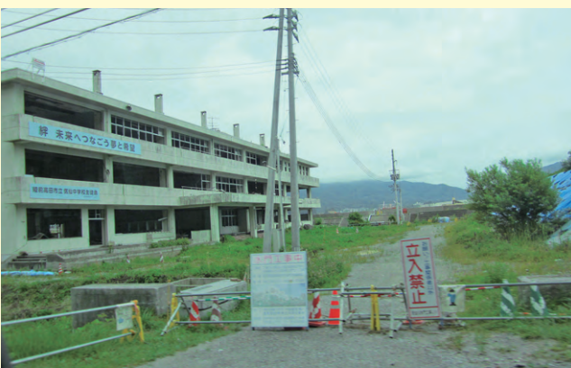
屋上まで津波にのまれたが、全員無事であった気仙中学校
