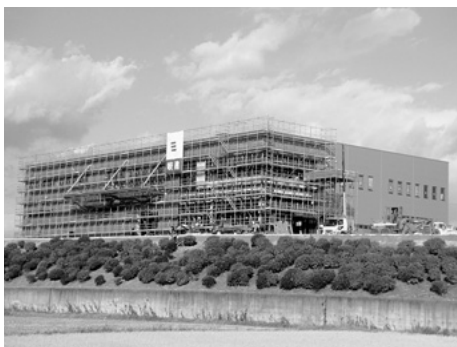
建設中の日成電機
