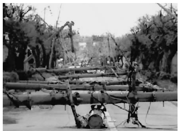
台風による電柱倒壊 平成15年台風14号(宮古島)
