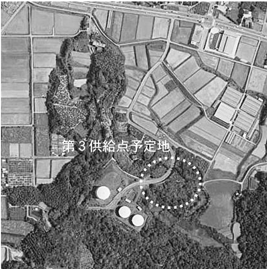
水道タンク予定地（板山地区）
