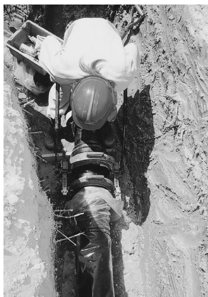
水道管布設工事
