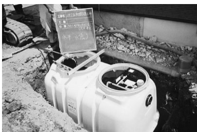
合併処理浄化槽
