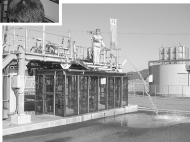
海洋深層水タンク▶
