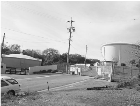
県と半田市の配水タンク
