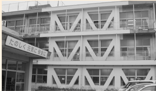
工事が終了した校舎（南部小）
