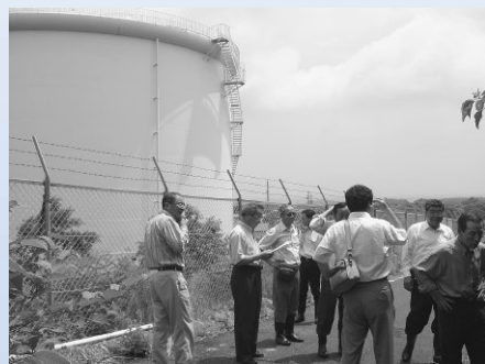
愛知県阿久比広域調整池(板山地区)
