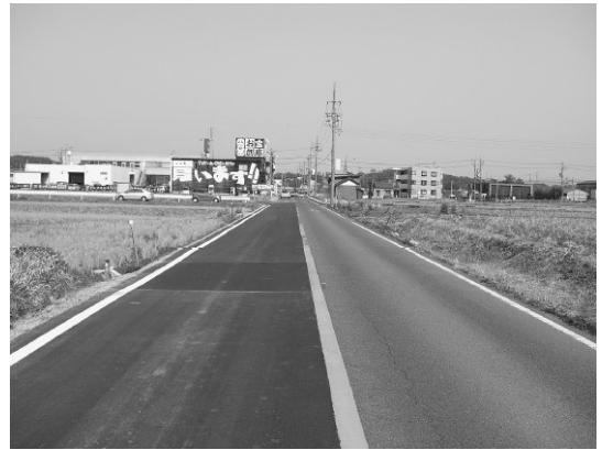
改修された町道113号線
