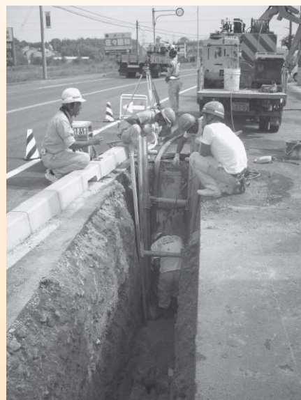
下水道工事(草木地区)
