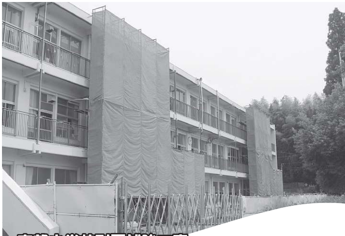
東部小学校耐震補強工事
