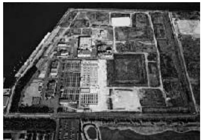
衣浦西部下水処理センター施設
