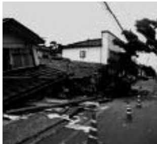
写真提供：首都大学東京土質研究室
