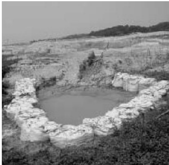
住宅に隣接する沈砂池
