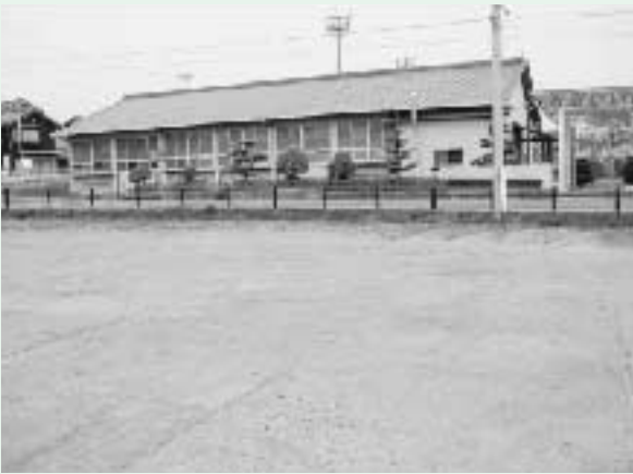
耐震性貯水槽建設予定地
