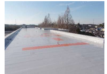
【阿久比中学校北校舎防水工事】
