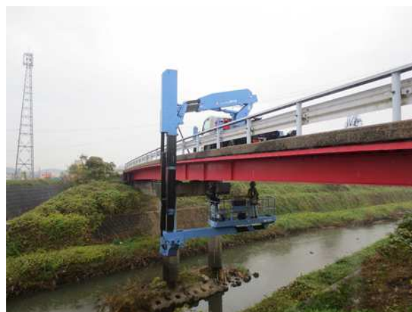
橋梁点検車による近接目視点検
