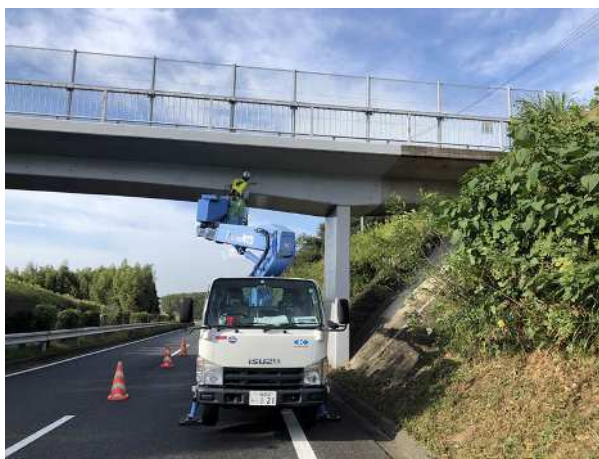
高所作業車による近接目視点検
