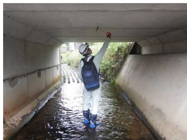
地上点検による近接目視点検
