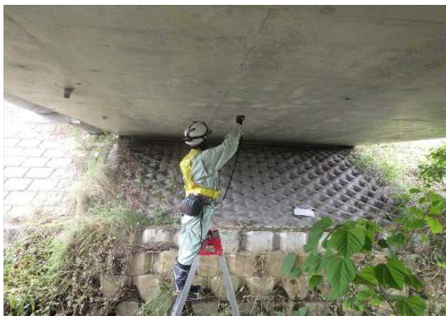
梯子による近接目視点検
