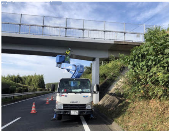
高所作業車による近接目視点検
