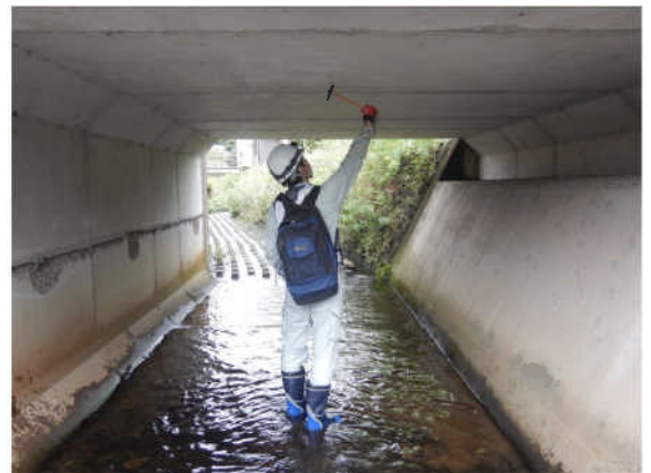
地上点検による近接目視点検
