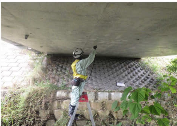
梯子による近接目視点検
