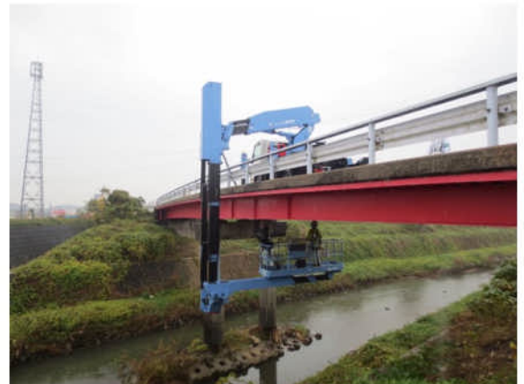
橋梁点検車による近接目視点検
