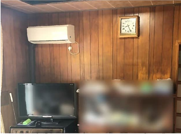
住宅の耐震改修（着手前）
