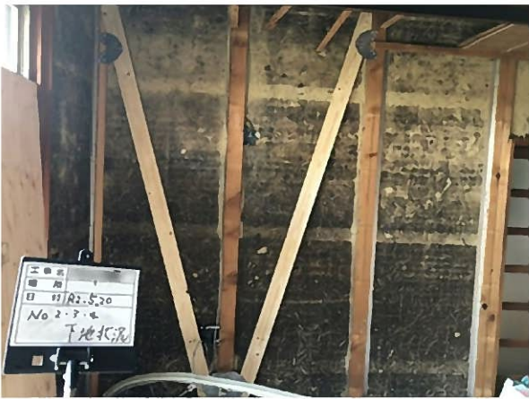
住宅の耐震改修（壁下地補強：筋交い・アングル）
