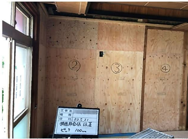
住宅の耐震改修（構造用合板設置：12mm）
