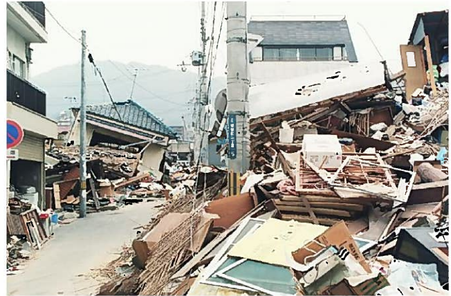
阪神・淡路大震災による住宅の倒壊（神戸市 HP より）
