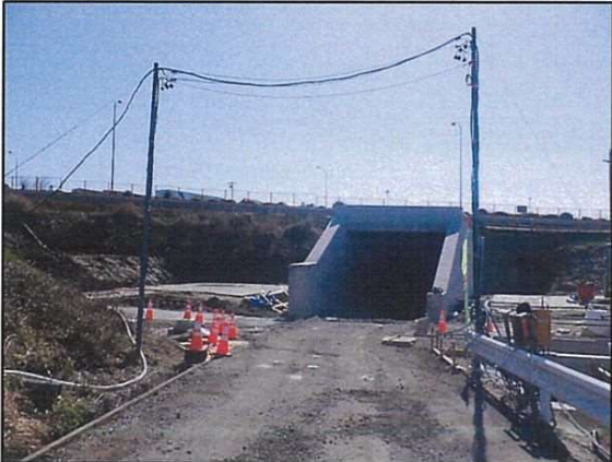
作業状況(知多半島道路下トンネル付近)
