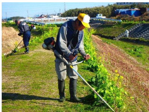
草木川堤防道路補修
