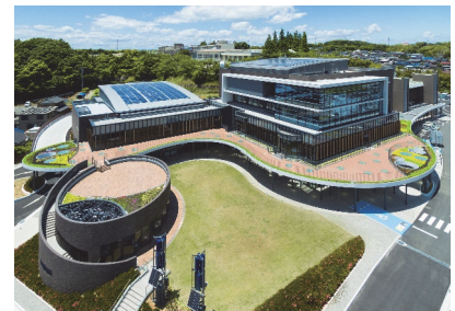
防災拠点の建て替え（新庁舎）
