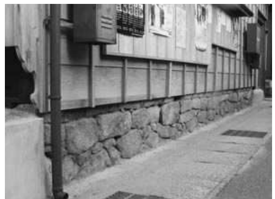
青年会場の基礎になっている「石垣」
