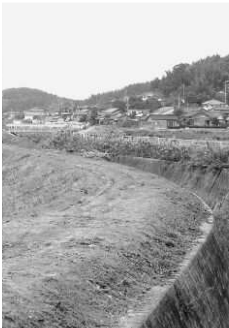
ぶらり歩いた前田川堤防
