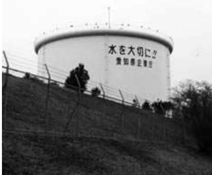
愛知県水道貯水施設の貯水タンク
