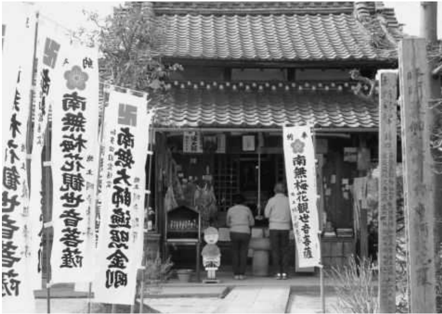
境内西側にある弘法堂
