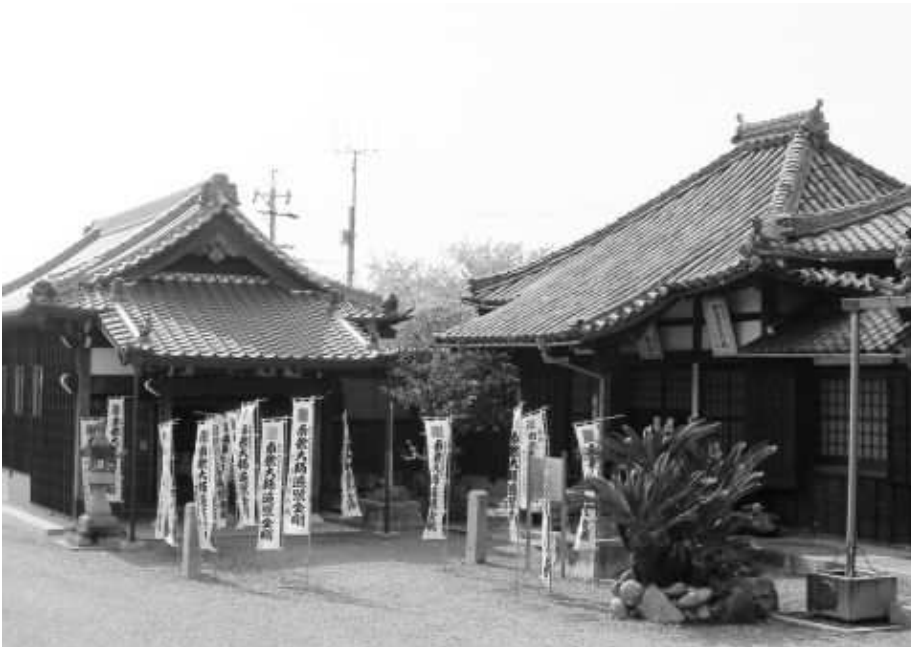
写真左：弘法堂 右：本堂
