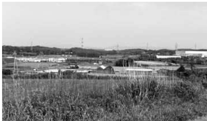
ハケ谷配水場から見た眺め
