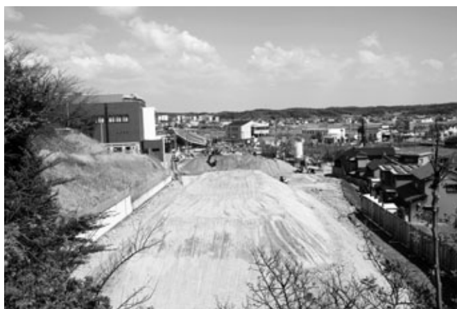
ホール棟、食堂棟の建設現場の様子
