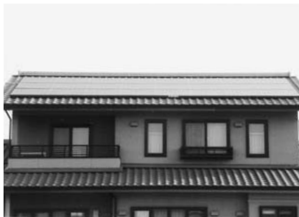
屋根の部分に取り付けられているのが太陽光発電システム
