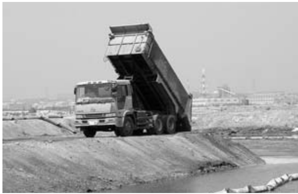
写真は衣浦ポートアイランド廃棄物最終処分場
