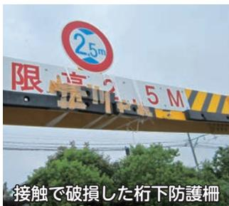
接触で破損した桁下防護柵
