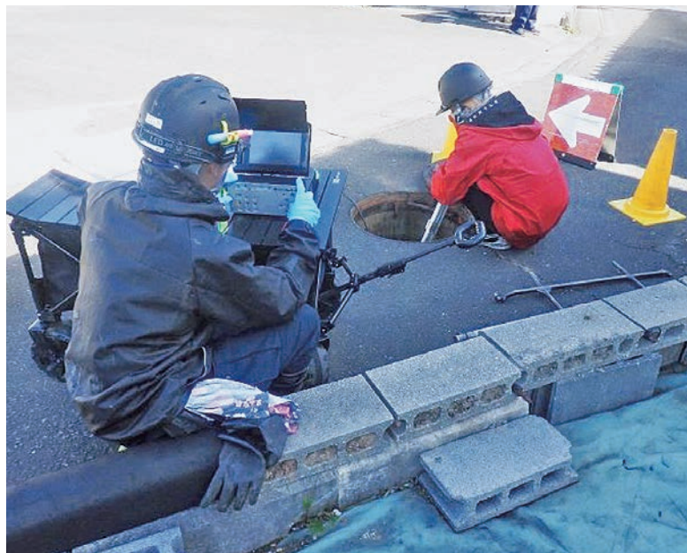
下水道管管内カメラ調査
