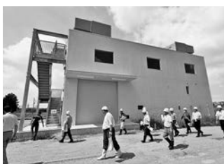
排水機場の外観（植大）
