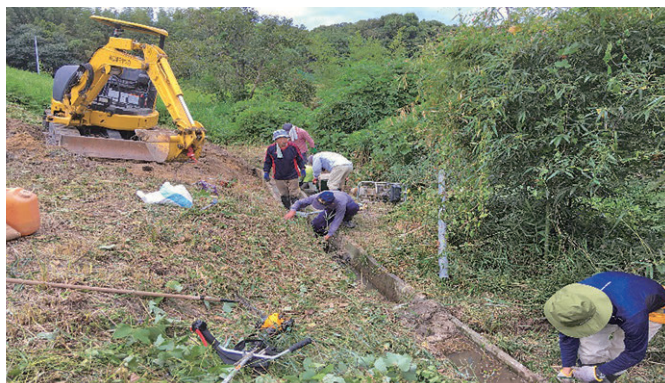
昨年7月の豪雨災害を受けた水路の修理風景
