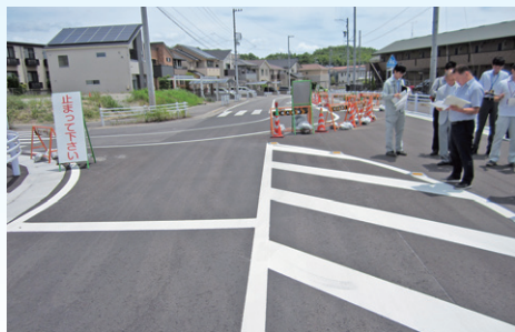
▲矢高横川線宮津地内
