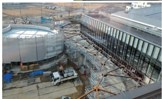
建設中の多目的ホールと食堂棟
