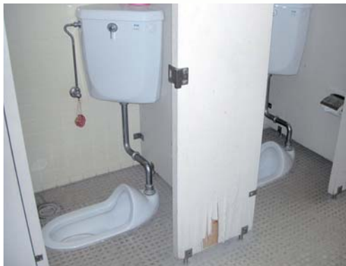
草木小学校のトイレ
