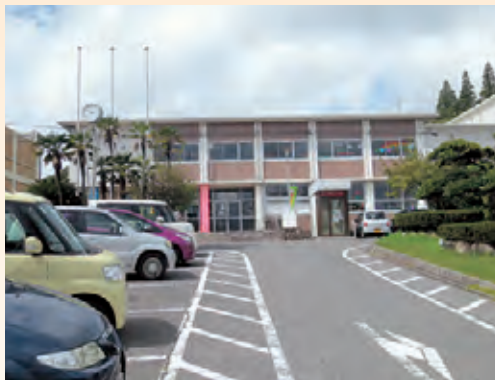
解体される中央公民館南館
