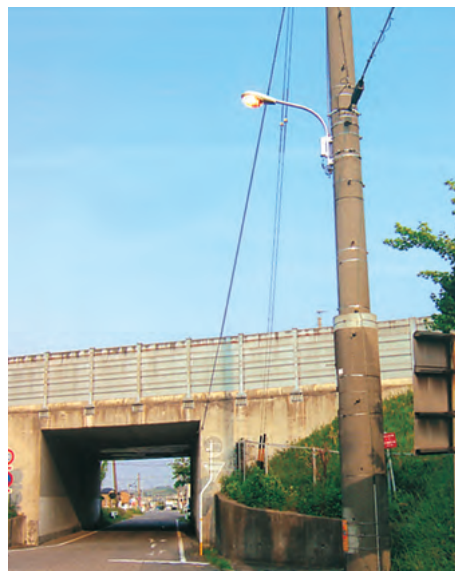
設置された防犯灯（阿久比インター東）
