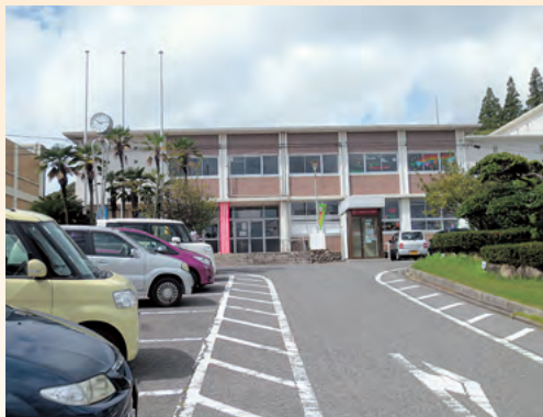
解体される中央公民館南館
