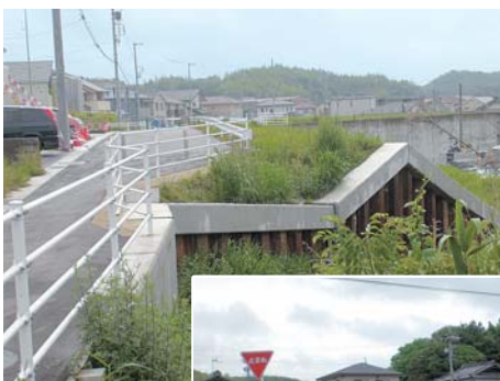
オアシス大橋東 未完成箇所
