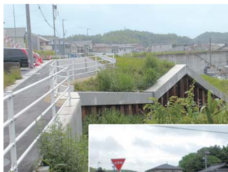
オアシス大橋東 未完成箇所
