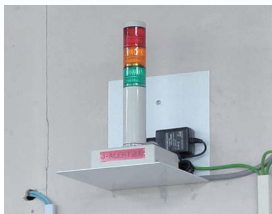
全国瞬時警報システム(Jアラート)の受信装置
