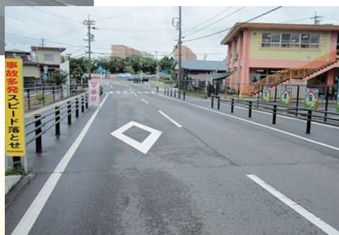
カラー舗装される宮津保育園前入口
