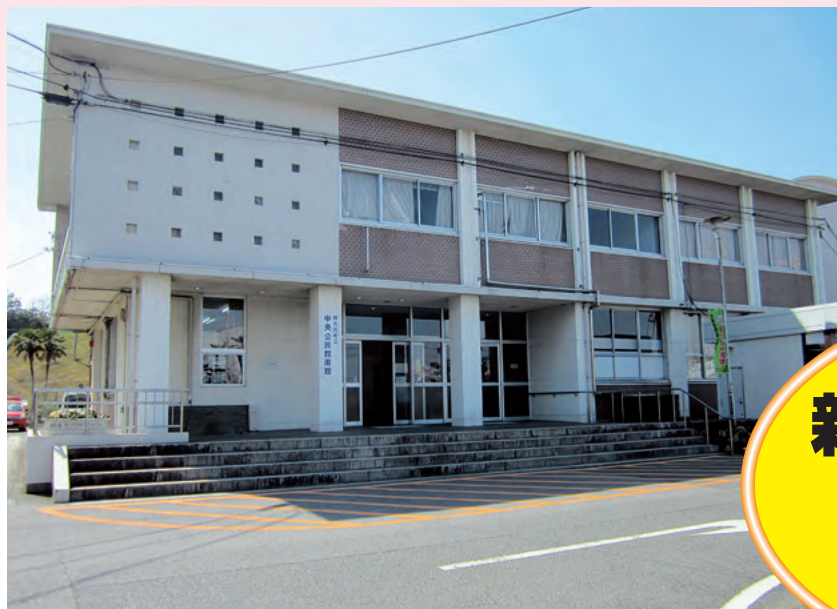
取り壊しが予定されている中央公民館南館
