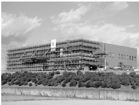
建設中の日成電機
