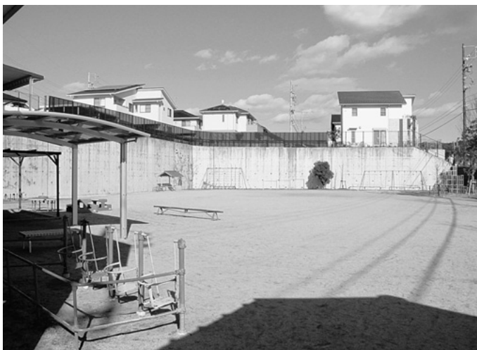
宮津保育園園庭の擁壁
