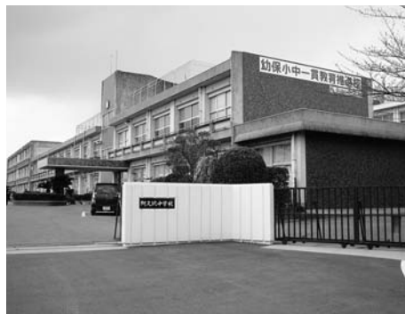
エアコンが設置される中学校
